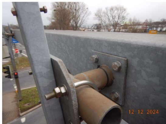
2024_BEFESTIGUNG DER VERKEHRSZEICHEN ANGEROSTET
