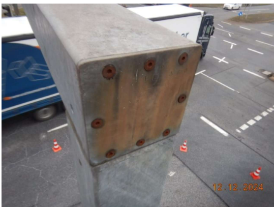
2024_REVISIONSÖFFNUNG ANGEROSTET
